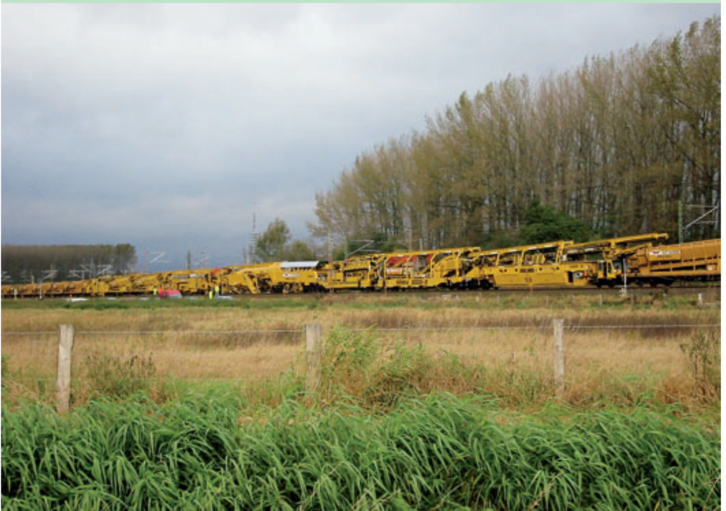
600 m lang kann eine Wiebe Gleisbaumaschine sein
